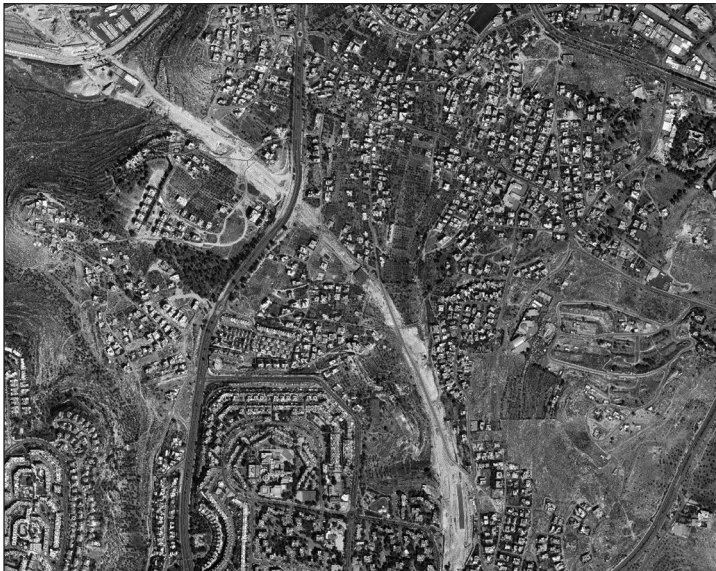
איור 1: בית צפאפא – כביש 4 בביצוע
